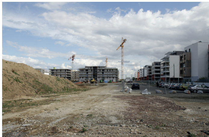
2012 - Les terres excavées sont stockées sur la piste
